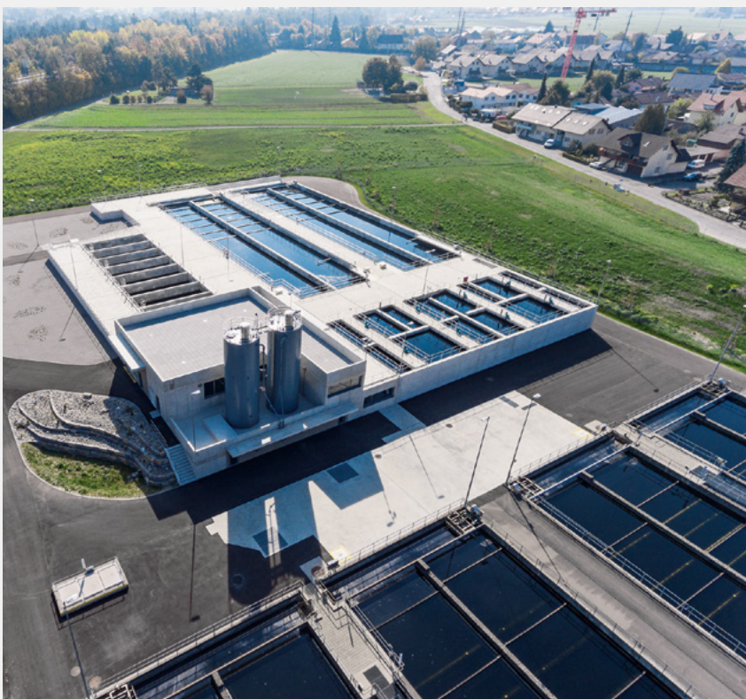
Fig. 1 PAK-Stufe der ARA Thunersee, mit Kontaktbecken, Sedimentation und Filtration
