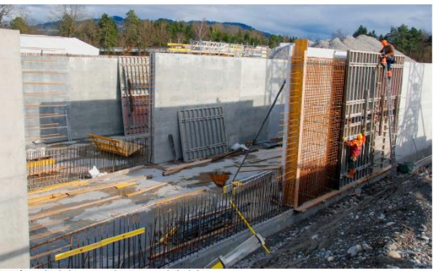
Letzte Woche: Zwei Arbeiter bei der Installation von Filteranlagen an einem der Abzweigungen.
