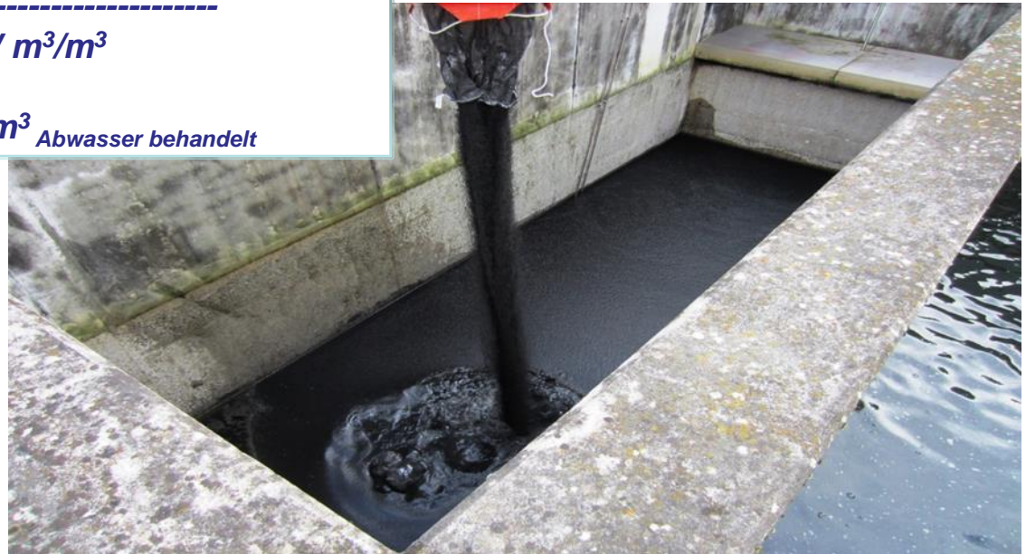
Befüllung einer Filterzelle mit GAK, ARA Furt, Bülach
