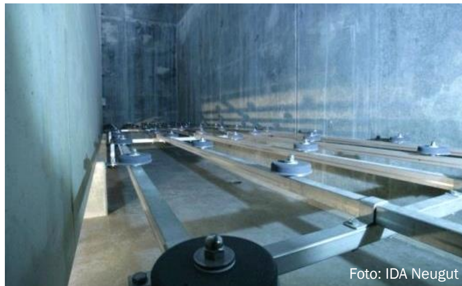
Rampa di immissione di ozono con diffusori ceramici
