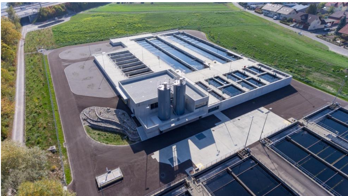
Fig. 1 Etape de traitement au CAP de la STEP de Thunersee, avec bassin de contact, sédimentation et filtration (source: M. Rindlisbacher, STEP Thunersee).
